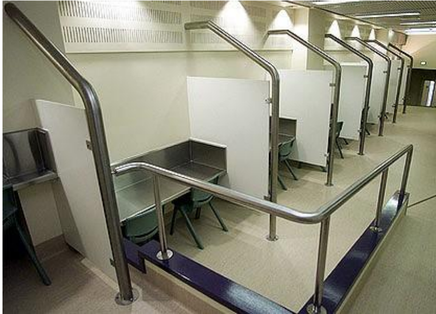
Stofindtagelsesrum i Canada
