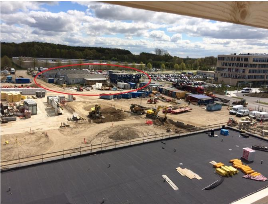
Figur 15: Billede over skurumskontorene på byggepladsen
