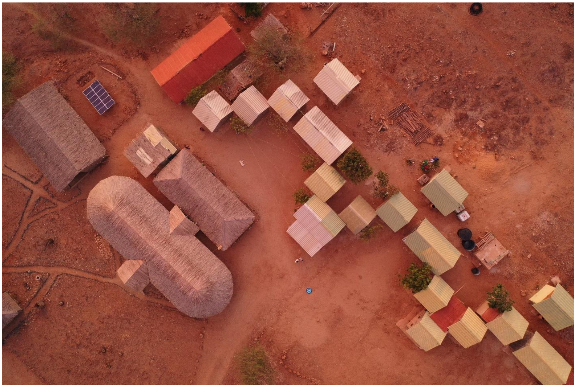
Foto 1.2. Panel solar en una cabaña [construcción típica], en La Guajira.
